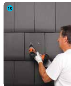
13 Przykręcamy dachówkę dwoma wkrętami
