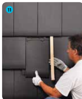
11 Wyciągnąć klin spod górnej dachówki
