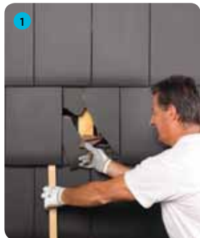
1 Umieścić pod lewą dachówką klin w celu łatwiejszego usunięcia uszkodzonej dachówki
