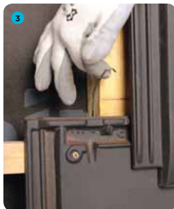
3 Naciągnięcie spinki w kierunku zamka dachówki
