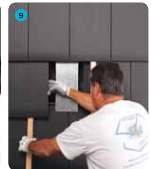
9 Włożyć klin pod lewą dachówkę
