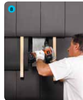
8 Przymocować płytkę do górnej łąty
