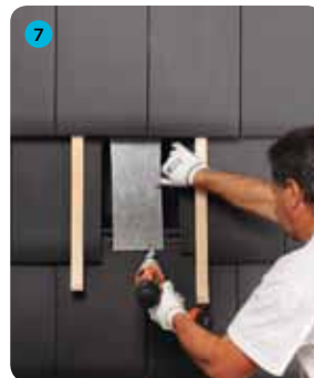
7 Przymocować płytkę za pomocą wkręta mocującego dolną dachówkę
