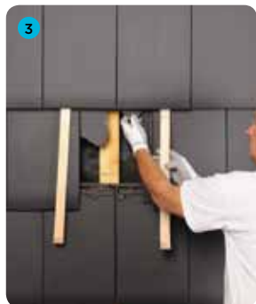
3 Umieścić klin pod prawą dachówką i usunąć resztki stłuczonej płytki
