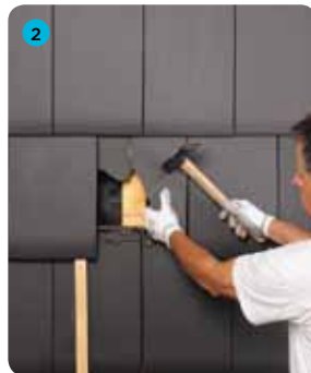
2 Usunąć uszkodzoną dachówkę
