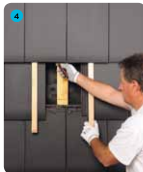
4 Wyciąć wkręt mocujący uszkodzoną dachówkę
