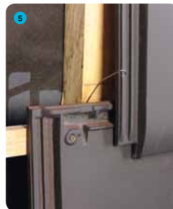
5 Montaż dachówki zakończony
