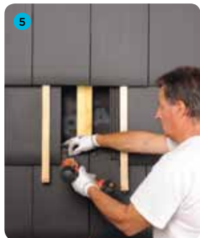
5 Usunąć wkręt mocujące dolną dachówkę
