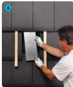
6 Umieścić metalową płytkę w miejscu wyjętej dachówki
