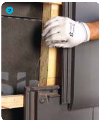
2 Zaczeplenie spinki o łatę
